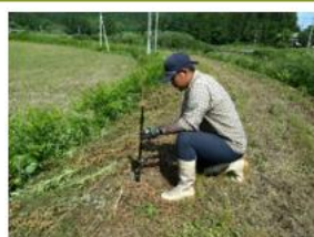
侵入防止の電気柵設置作業
