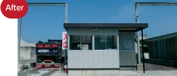
建て替え後の堺臨海営業所
