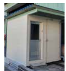
泉北第2倉庫女子トイレ
