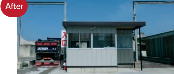
建て替え後の堺臨海営業所
